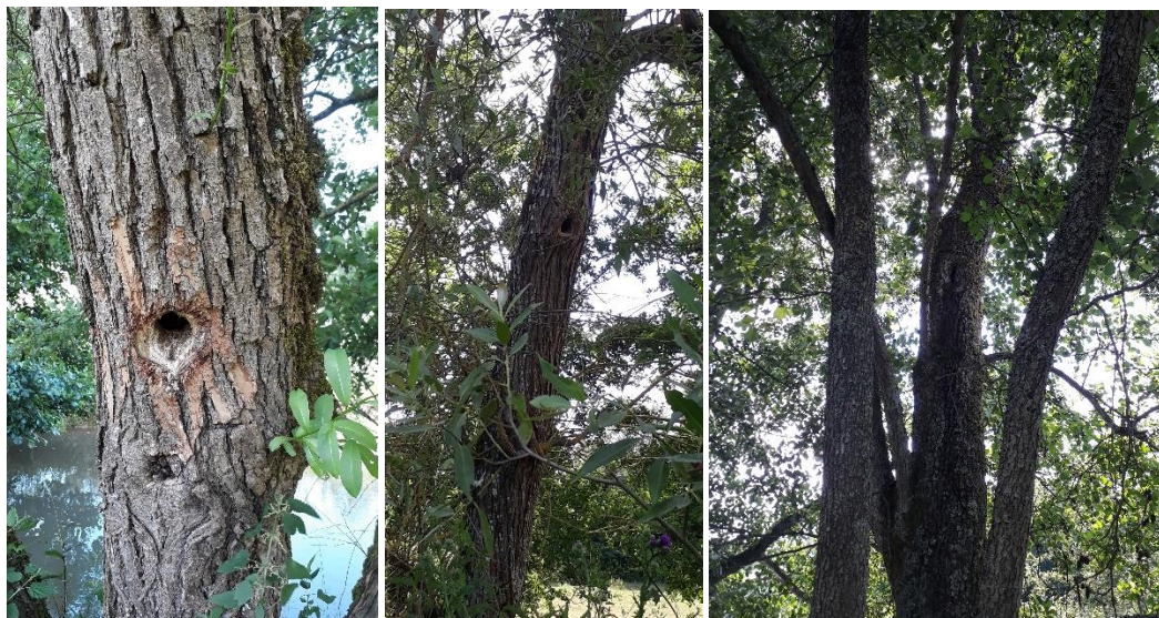
Présence de plusieurs arbres avec cavités, fissures pouvant servir de gîtes aux chauves-souris
